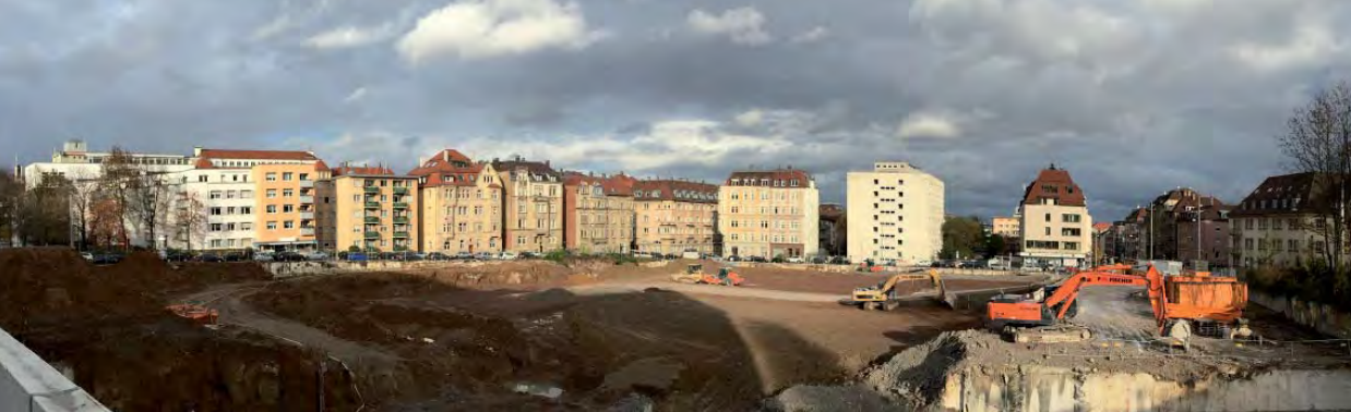
BILD Baugrube Olga-Areal (Christine Falkner)
