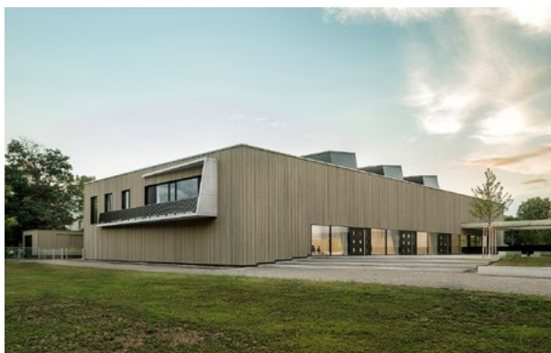
Außenansicht Turnhalle Fasanenhofschule
