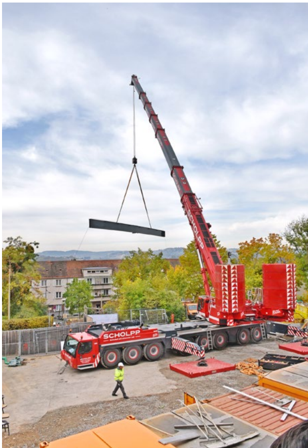
Stahlträger fliegen ein
