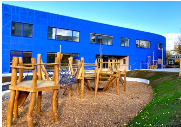
Außenansicht Schulhof Süd, Eingangsbereich
