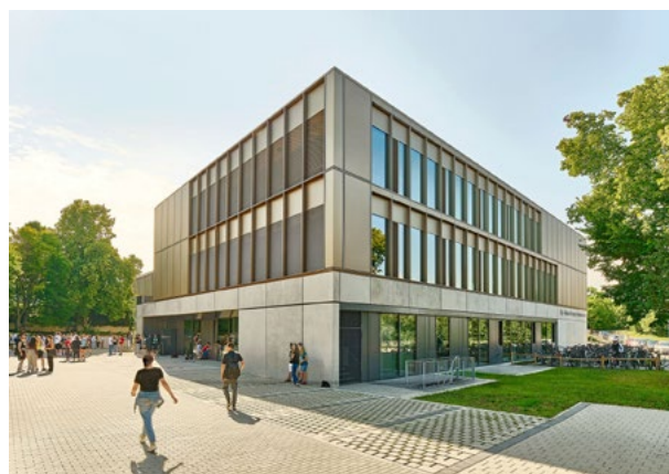
Nordwestansicht des ersten Bauabschnitts. Die Fassade zeichnet sich durch Sichtbeton im Erdgeschoss und bronzefarbene Fassadenelemente in den Obergeschossen aus
