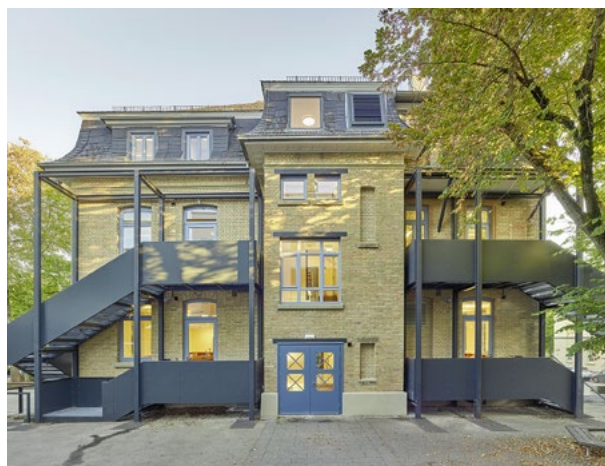
Gebäuderückseite mit aufwendiger Fluchttreppenkonstruktion
