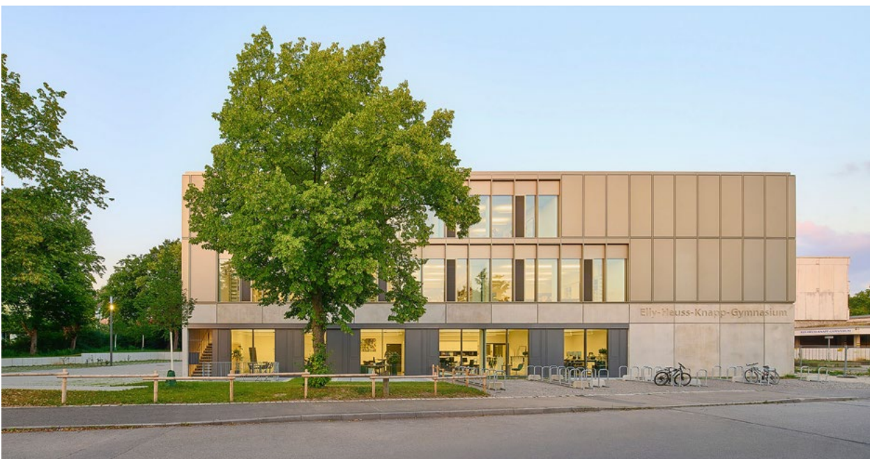
Blick auf die Westfassade von der Remstalstraße. Im Erdgeschoss befinden sich im Westflügel die Räume der Verwaltung; ganz rechts ist angeschnitten das Bestandsgebäude zu erkennen
